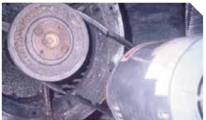
ファンベルトは定期的にチェックし、必要に応じて交換します—このベルトは使用不適。
